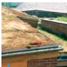
Toitures végétalisées, lycée Jacquard, Caudry
