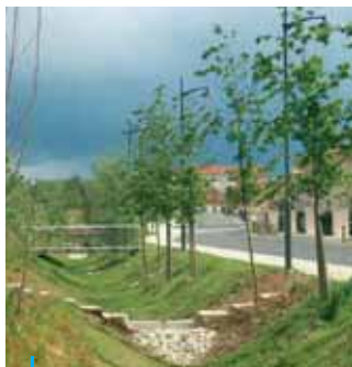
Noues cloisonnées, Parc Bouglione, Corbas
