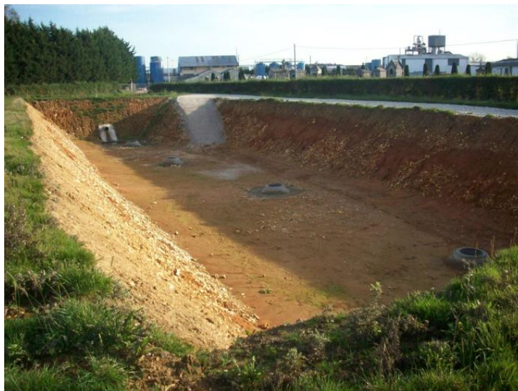
Exemple de bassin d'infiltration réalisé par Verdi Ingénierie
