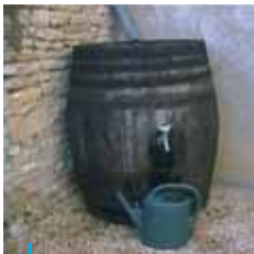
Citerne de récupération des eaux pluviales
