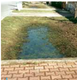
Noue en eau, Bordeaux
