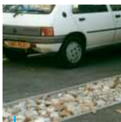
Tranchée d'infiltration
