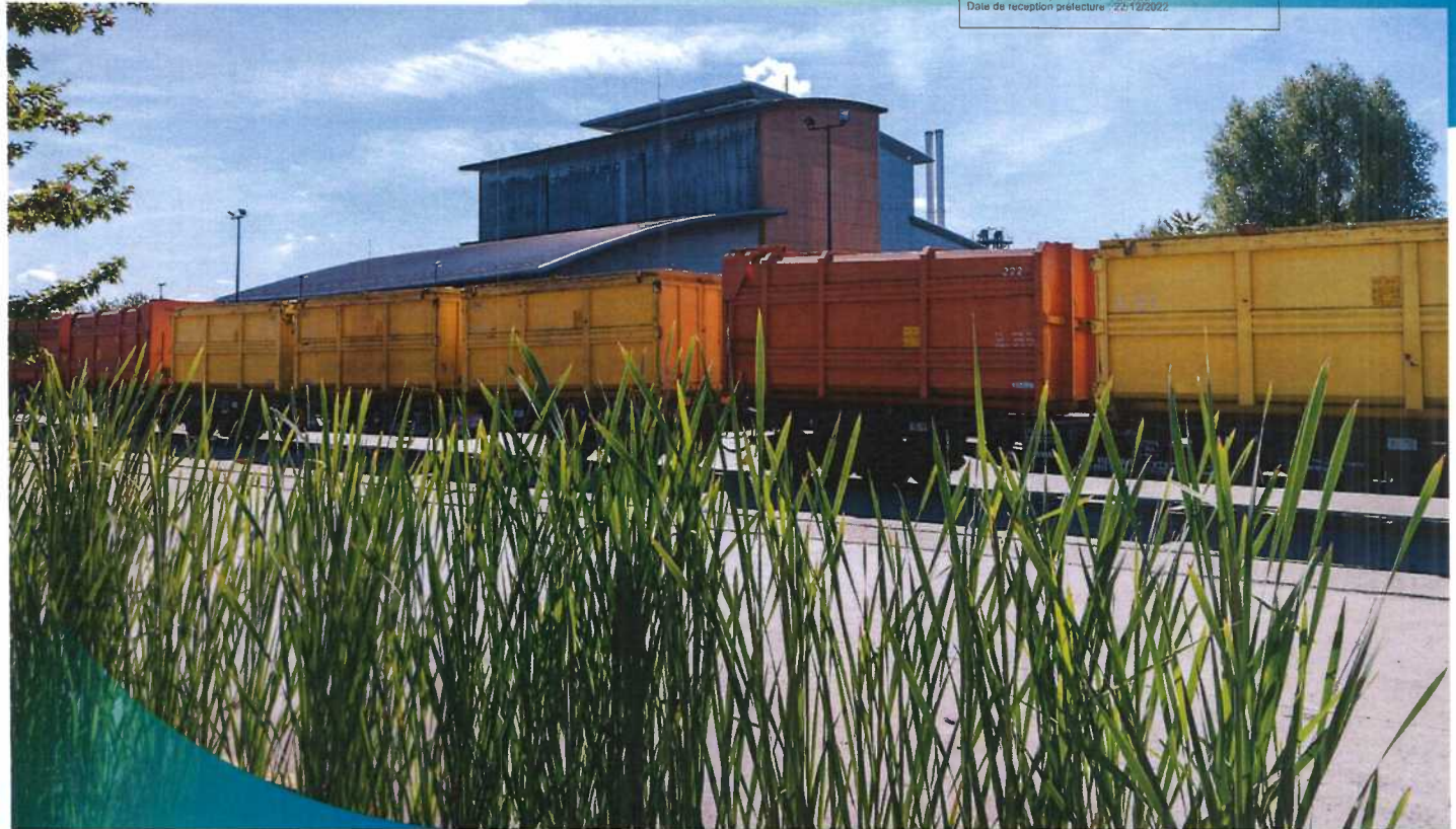
Plateforme ferroviaire de Villers-Saint-Paul
