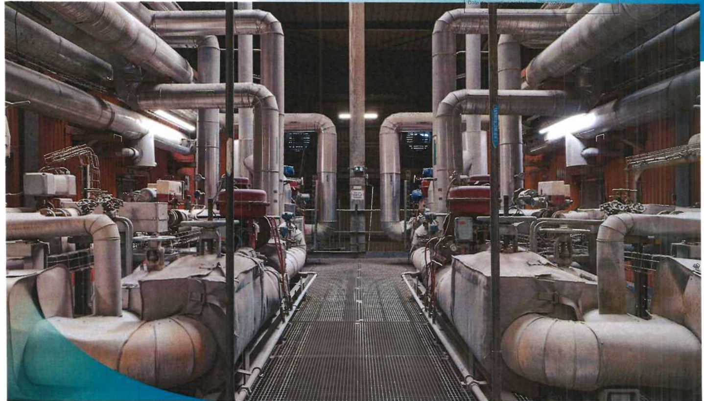
Panoplies eau/vapeur des chaudières du Centre de Valorisation Énergétique de Villers-Saint-Paul
