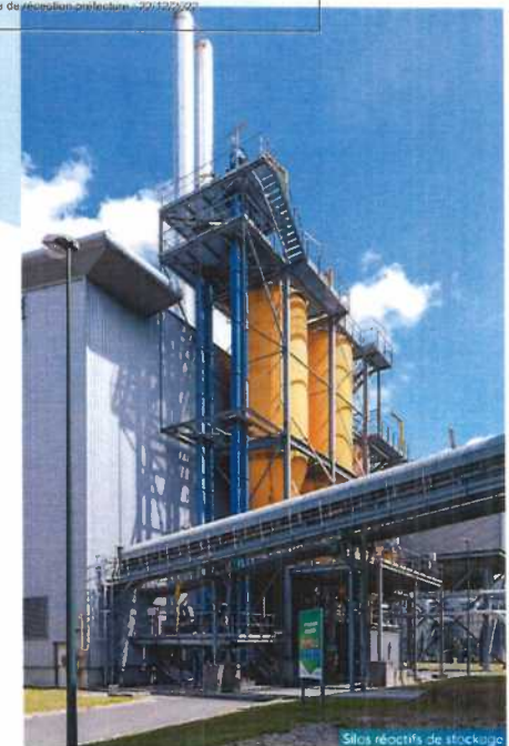
Silos réactifs de stockage
