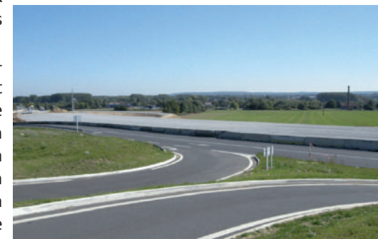
Echangeur de la RD1032
