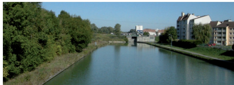
Canal du Nord et frange urbaine de Noyon
