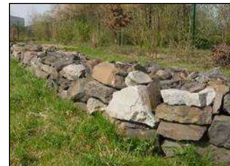
Photo 6. Muret de pierres sèches
