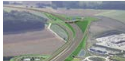
La nouvelle RD1032 au niveau du Mont-Renaud
